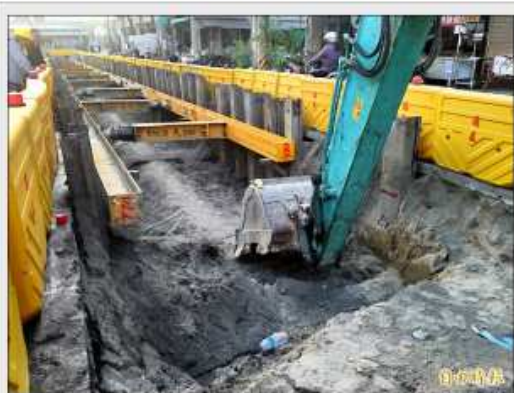
市府水利局針對楠梓區易淹水地區，推動排水改善工程，圖為樂群路施工時的狀況。（記者陳文嬋攝）
